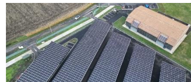
Ombrières photovoltaïques à Lussat Crédit photo : Apex Energies
