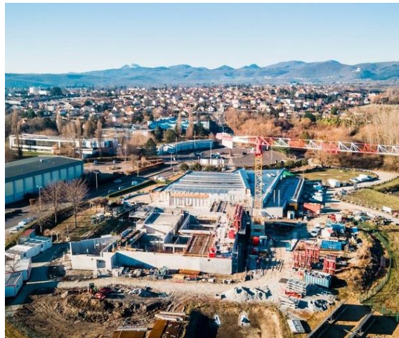
Travaux du centre aqualudique Béatrice Hess
