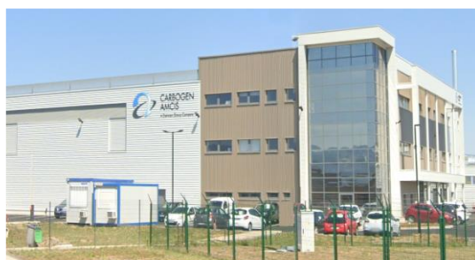
Carbogen, ZAC du Biopôle : construction en R+2
