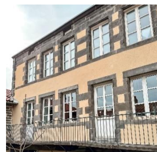
Rénovation d'un logement locatif à Volvic
