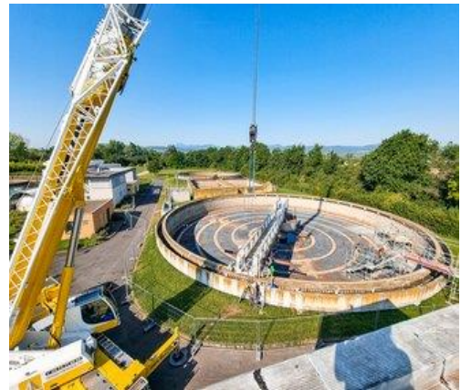
Travaux 2023 de la station de traitement des eaux usées de Riom
