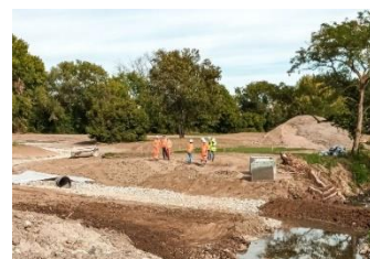
Travaux de renaturation et découverte de l'Ambène
