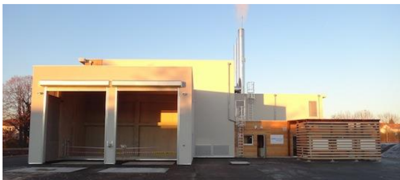
Vue du bâtiment de la chaufferie RCBE
