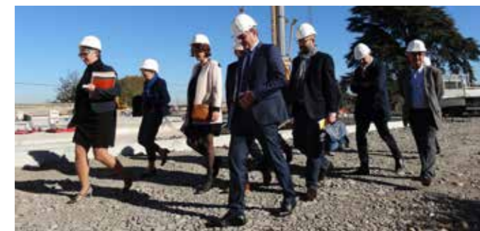
Visite du chantier des Jardins de la Culture avec M. Préfet
