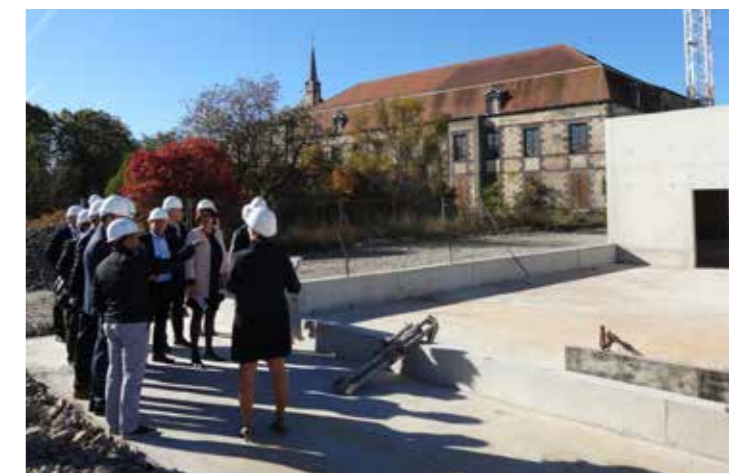
Chantier des Jardins de la Culture
