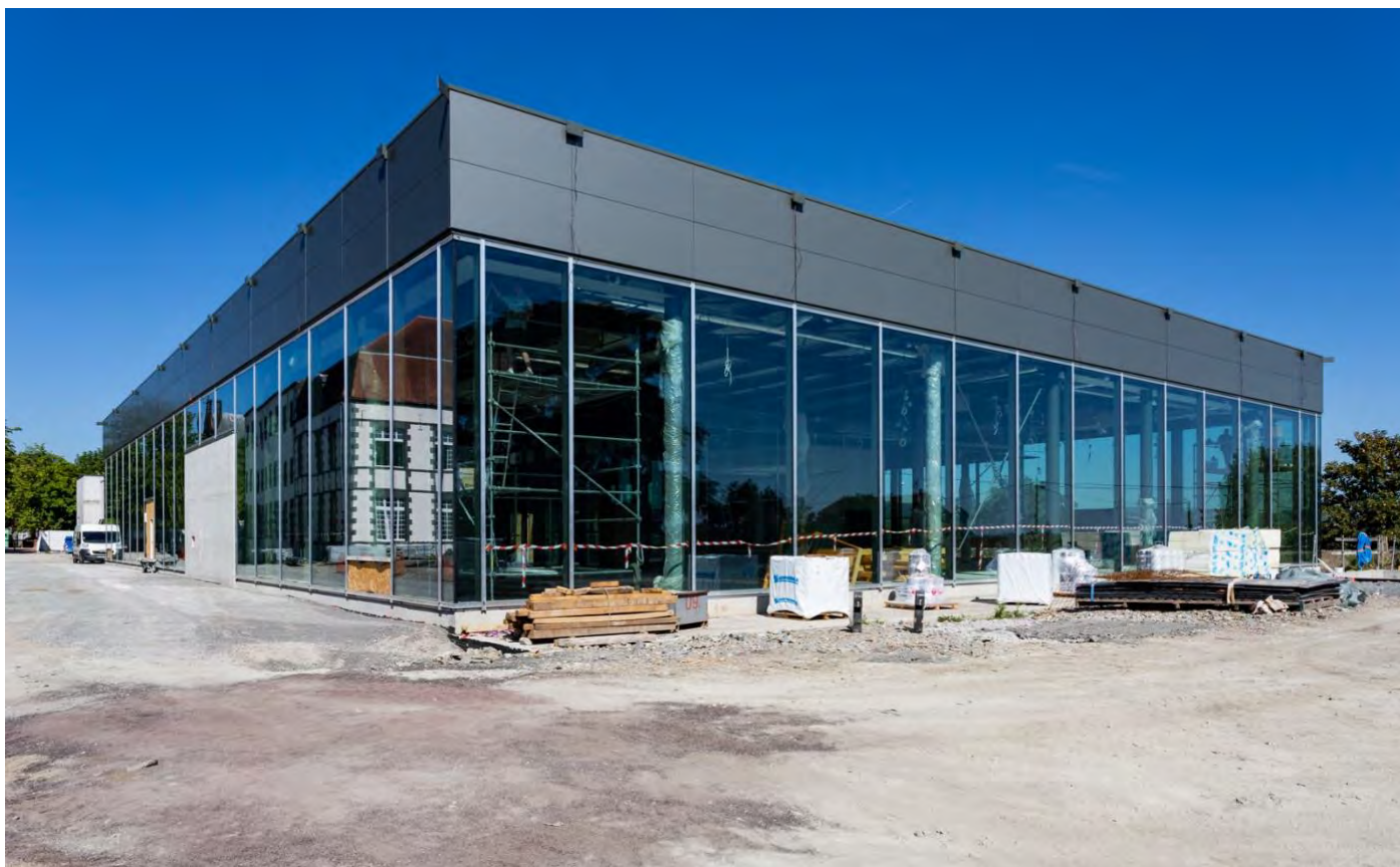
Chantier de la médiathèque des Jardins de la Culture (août 2018)
