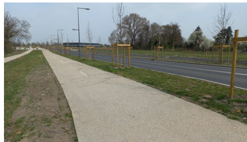
Chantier voie sud (mars 2022, SPL CA)
