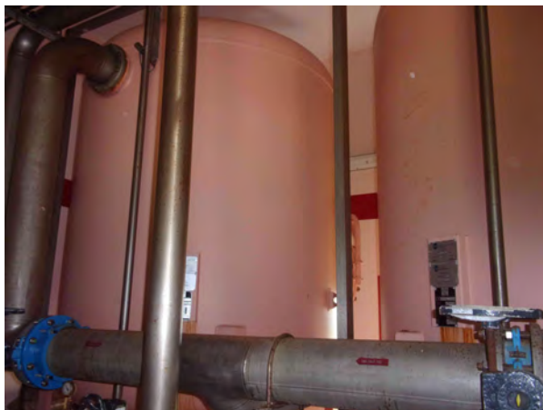
Intérieur de la station de traitement
