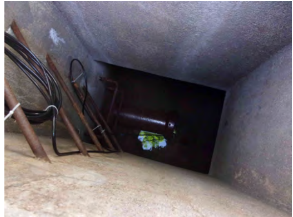
Intérieur de l'ouvrage muni d'une échelle
