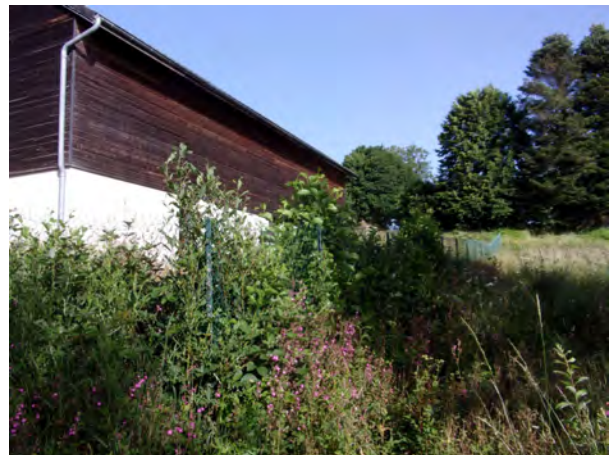
Clôture en place autour de la station de traitement
