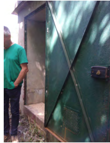
Porte d'entrée du captage
