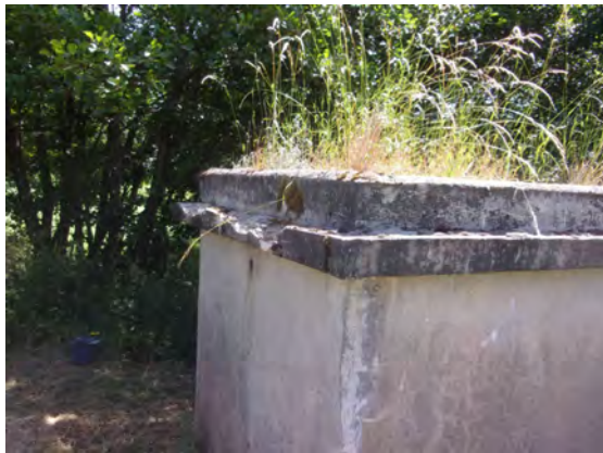
Partie supérieure du captage à restaurer
