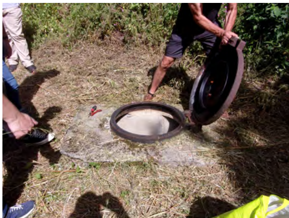
Aération à placer sur la plaque en fonte et décaissement de la dalle à béton
