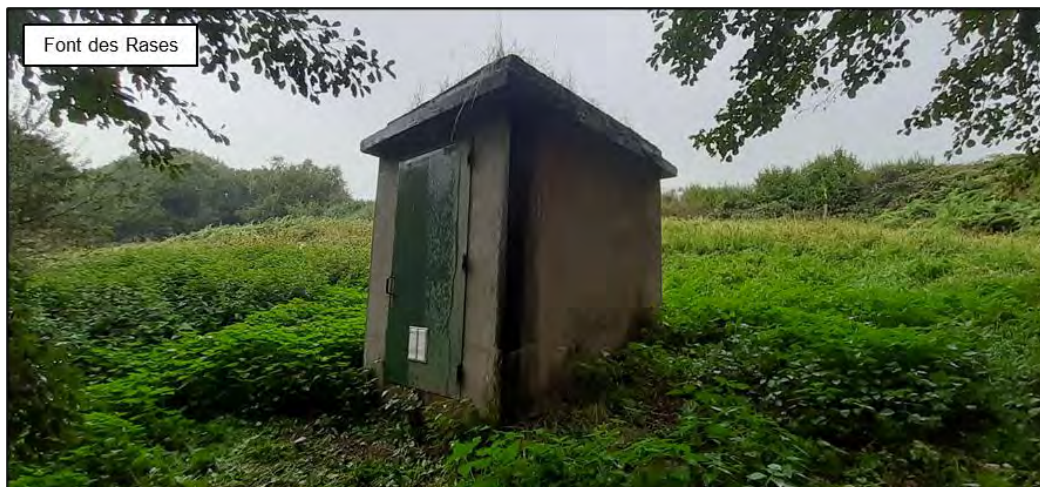
Figure 8 : Vue satellitaire de l'environnement immédiat des captages et photographie du captage de Font-des-Rases
