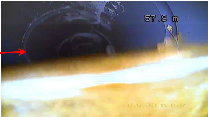
Vue des crépines avec augmentation des dépôts sur le fil d'eau
