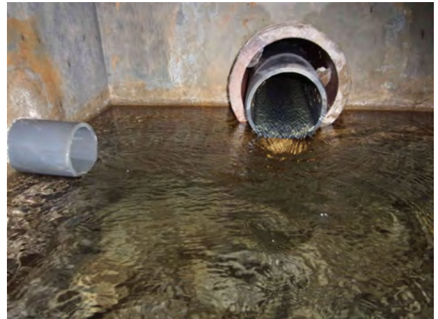
Arrivée des deux drains dans le bac de prise
