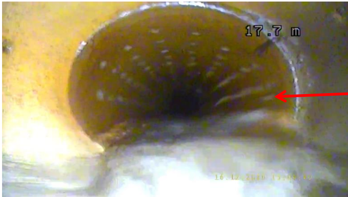
Vue de la fin de la conduite avec les pierres taillées et les racines.
