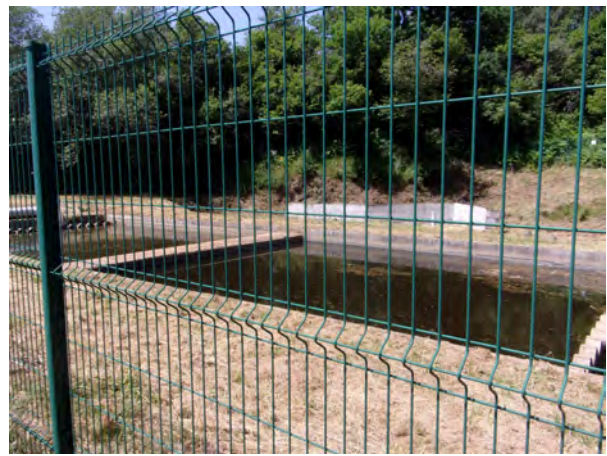
Partie terminale du bassin de traitement
