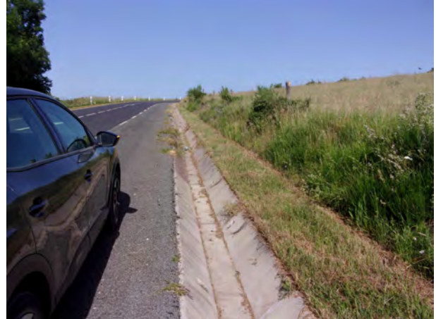
Route départementale D90 et son caniveau situé dans le futur PPR
