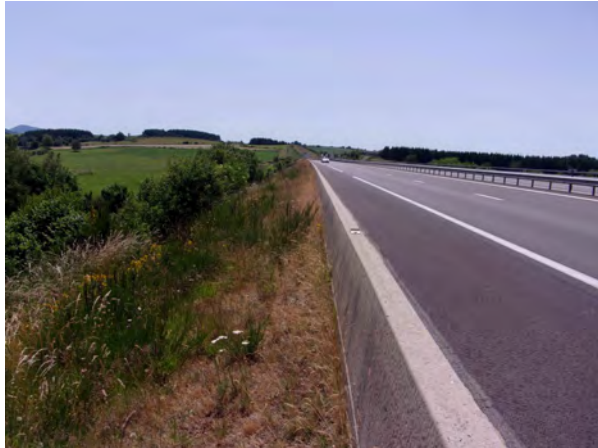
Partie de l'autoroute A89 qui longe le bassin de Font des Rases
