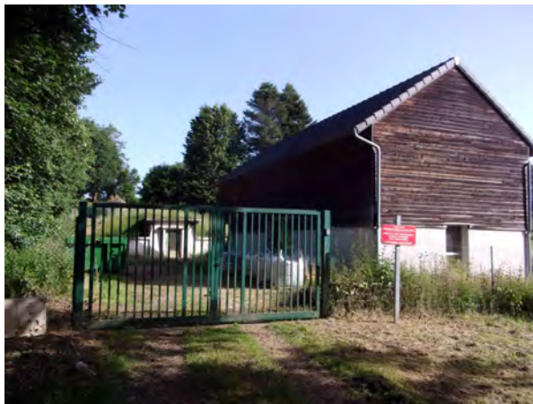
Portail d'entrée dans le premier périmètre et station de traitement
