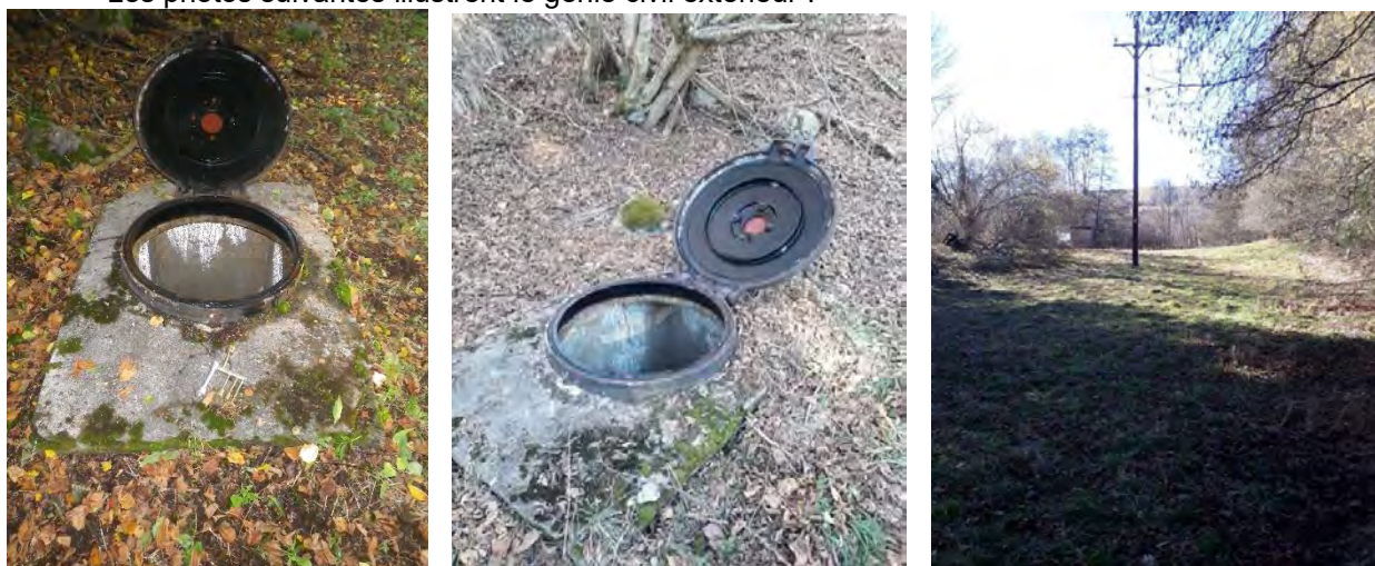
Vue de l'extérieur du captage et de son environnement
