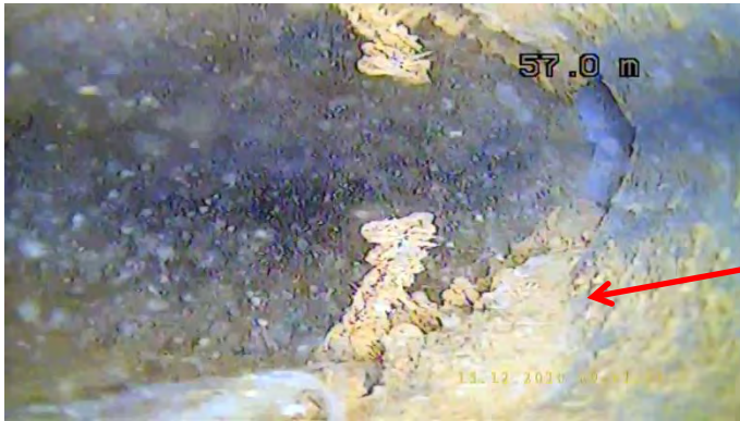
Vue des crépines et des dépôts orangés
