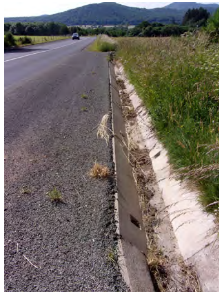
Route départementale D90 et son caniveau dans la partie supérieur du bassin d'alimentation
