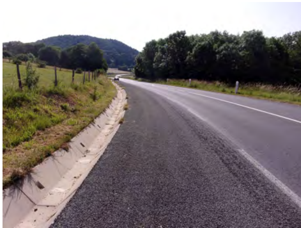
Route départementale D90 et son caniveau juste au dessus du captage de Font des Rases
