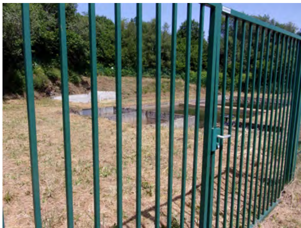
Bassin de traitement des eaux provenant de la partie Ouest de la commune de CHARBONNIERES-LES-VARENNES et incluant les eaux de trop plein des captages de Font des Rases et Le Pêcher
