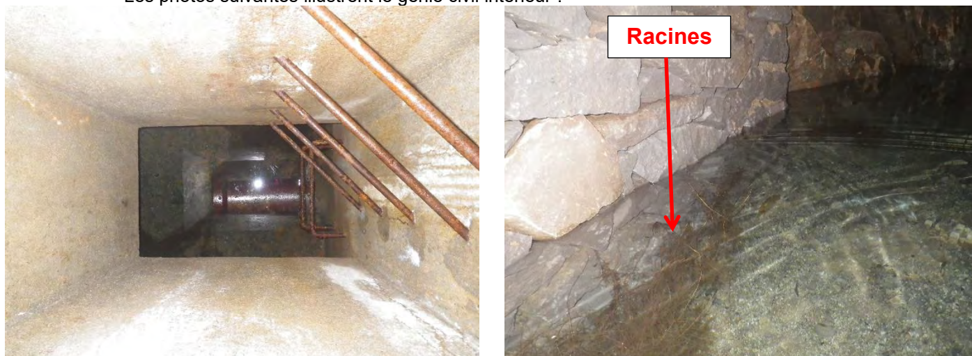
Vues de l'intérieur du captage
