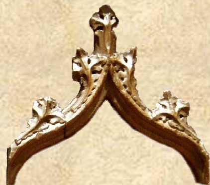
▲ Arc en accolade
