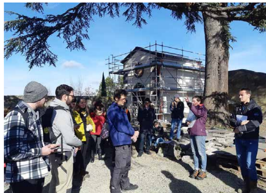
Visite sur le chantier des Jardins de la Culture
