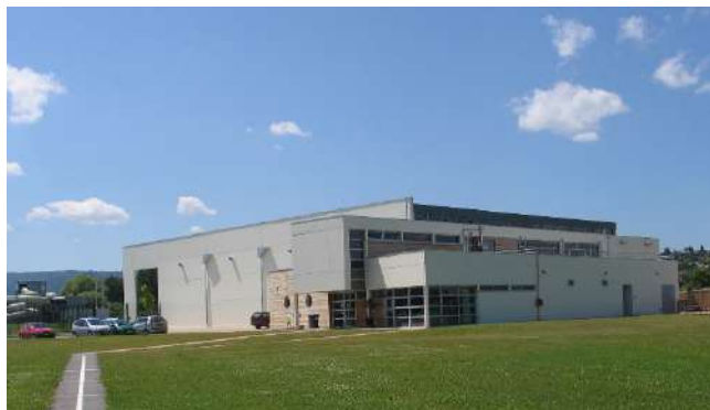
Centre Régional de Tir à l'arc
