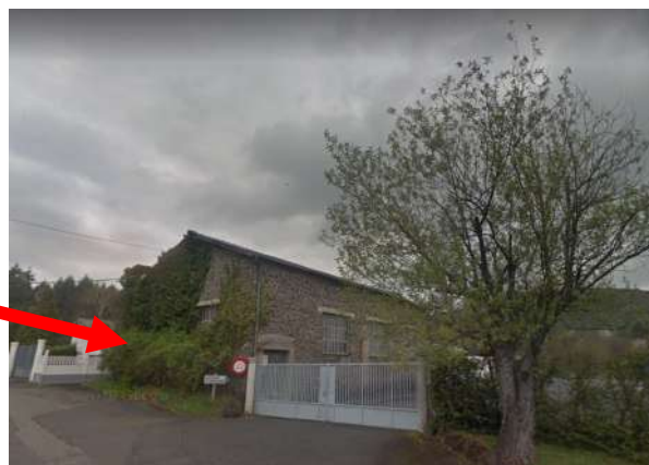
Bâtiment de la future maison de site
